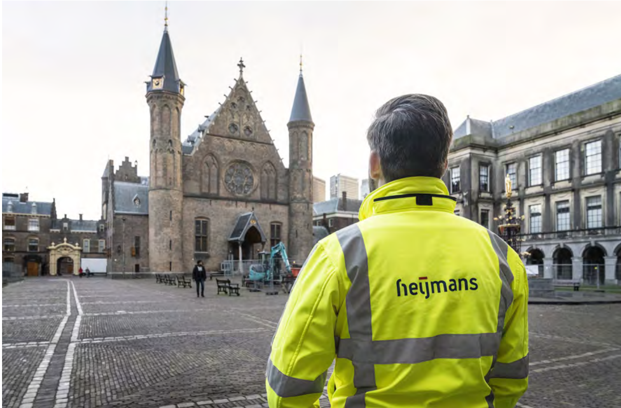
Renovation Binnenhof in Den Haag
